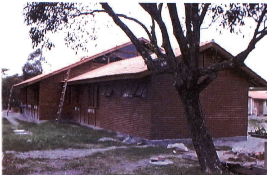
Detalhe da ampliação da residência do morador veranista fora do padrão
