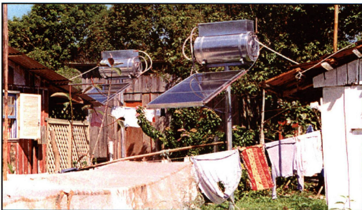
Figura 4.10 – Sistema de aquecimento solar instalado na Ilha do Mel.
