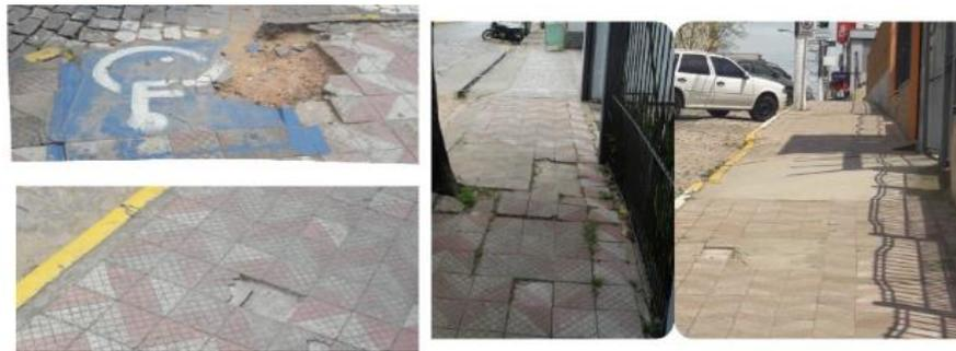
Figura 2 – Buracos devido a remoção de peças soltas de ladrilho hidráulico e desníveis
