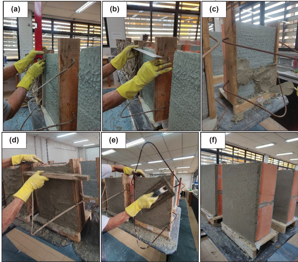
FIGURA 33 – Execução do revestimento de argamassa: conferência do nível (a); conferência do alinhamento (b); aplicação da argamassa sobre a superfície (c); sarrafeamento da superfície (d); desempenamento da superfície (e); prismas finalizados com gabaritos removidos (f)
