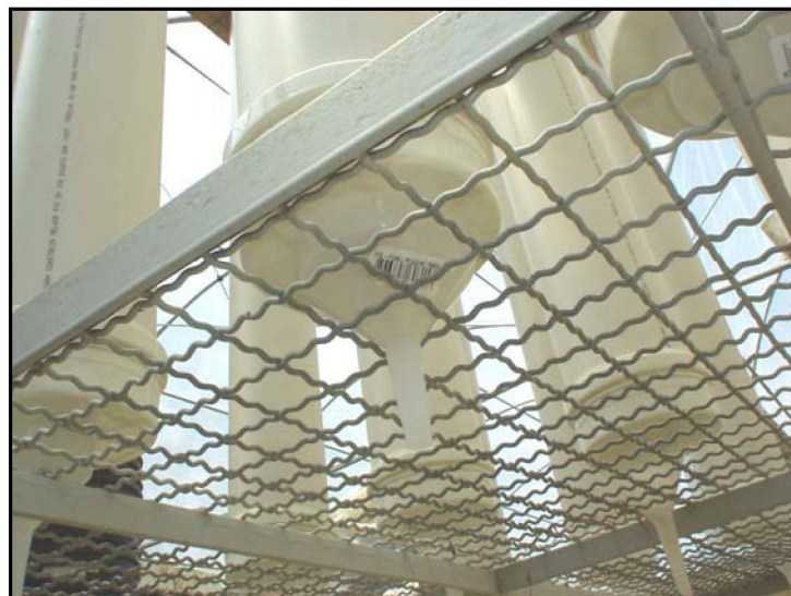
FIGURA 16 – DETALHE DOS FUNÍIS INSTALADOS NA PARTE INFERIOR DOS TUBOS DE PVC PARA A CAPTAÇÃO DA SOLUÇÃO PERCOLADA ATRAVÉS DAS COLUNAS DE SOLO
