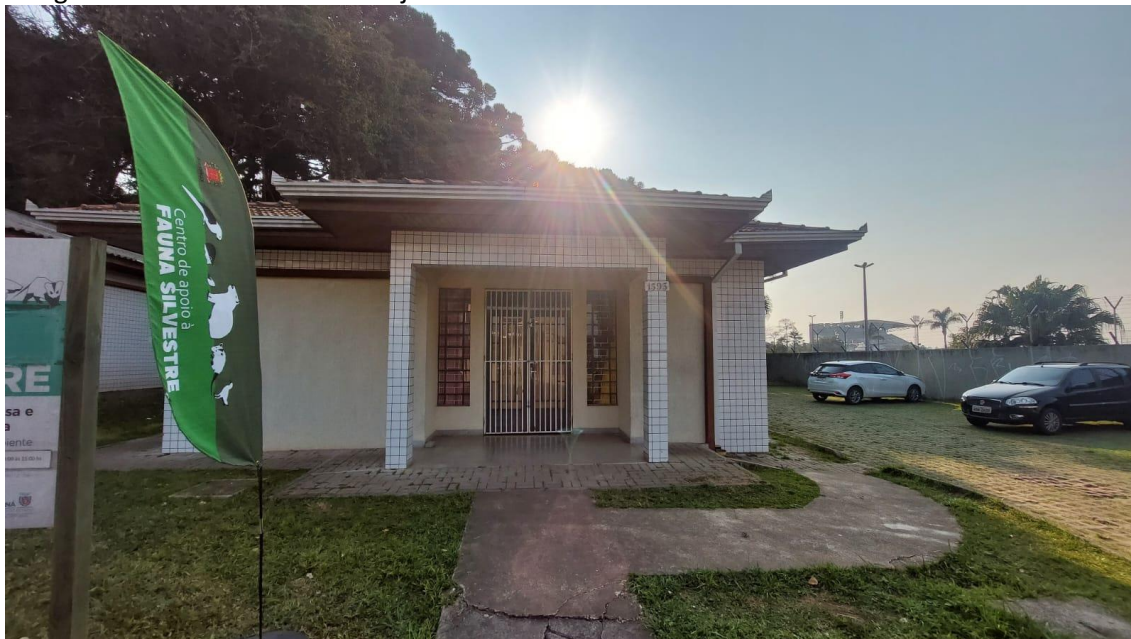
Figura 1: Vista frontal da fachada da sede do CAFS. Durante o período de estágio supervisionado obrigatório de 7 de maio a 30 de julho de 2024.
