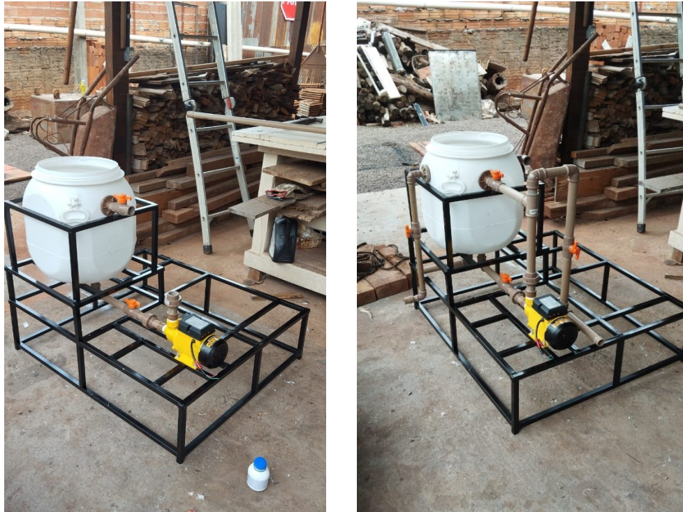
Figura 13 – Montagem das tubulações
