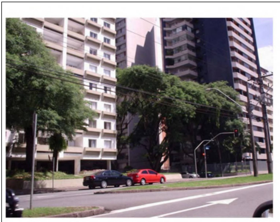
Fotografia 14 – Vista de edifícios no SEE-SL.
