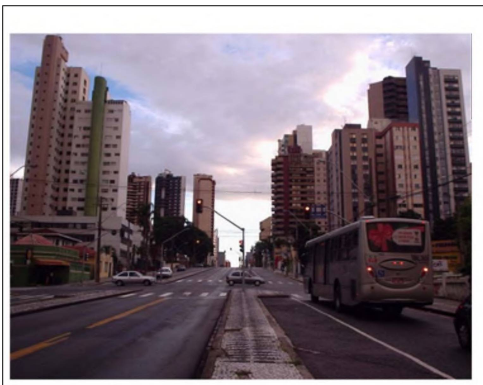
Fotografia 6 – Vista da canaleta do expresso no SEE-N.
