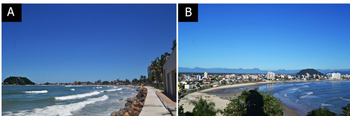
FIGURA 13 - PRAIA CENTRAL DE GUARATUBA: PORÇÃO CENTRAL (A) COM EVIDÊNCIAS DE EROSÃO; PORÇÃO SUL (B), COM FAIXA DE AREIA MAIS EXTENSA E DEMONSTRAÇÃO DO REPRESAMENTO DA DESCARGA DE GALERIA PLUVIAL VISTA DO MORRO DO BOI.
