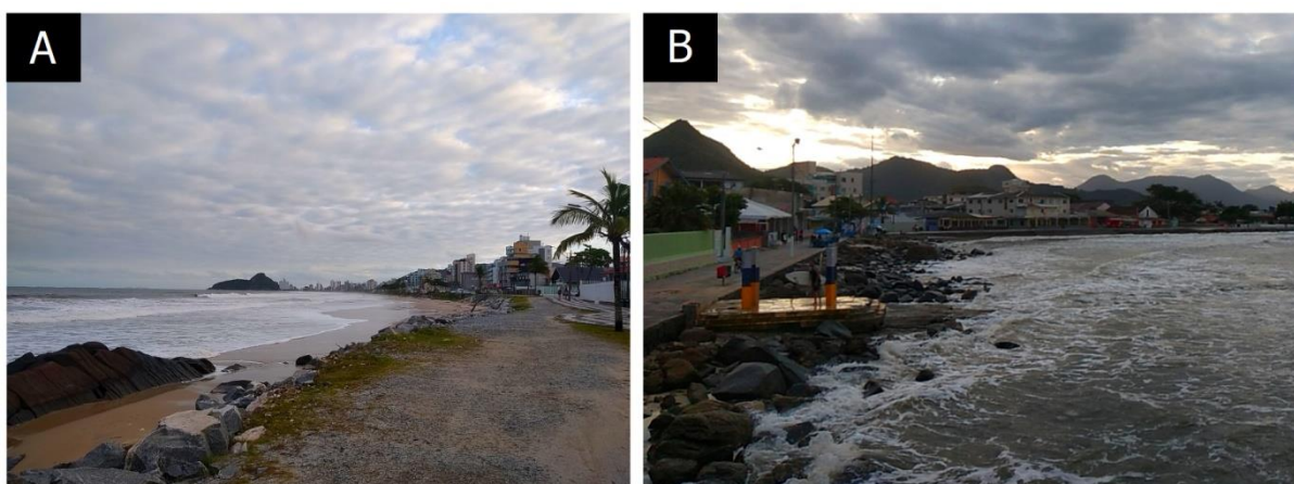
FIGURA 23 – AMBIENTE PRAIAL DELIMITADO POR MUROS E ENROCAMENTOS NA PORÇÃO NORTE DA PRAIA BRAVA (A) E NA PORÇÃO SUL DA PRAIA DO RIO MATINHOS (B), AMBAS EM MARÉ ENCHENTE
