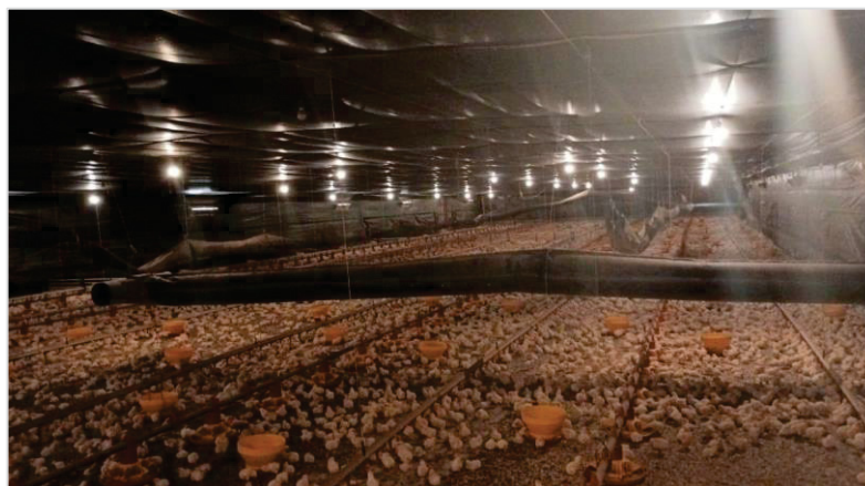
FIGURA 21 - Tubo de distribuição de calor
