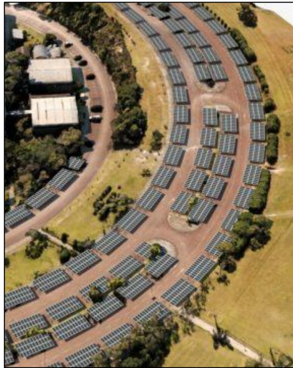
Figura 4 - Usina Fotovoltaica do Centro Politécnico da Universidade Federal do Paraná
