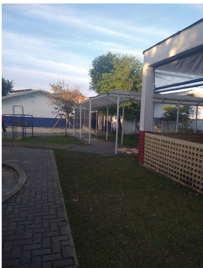
FOTO 12- PASSAGEM COBERTA ENTRE OS DOIS CMEIs – CMEI BP
