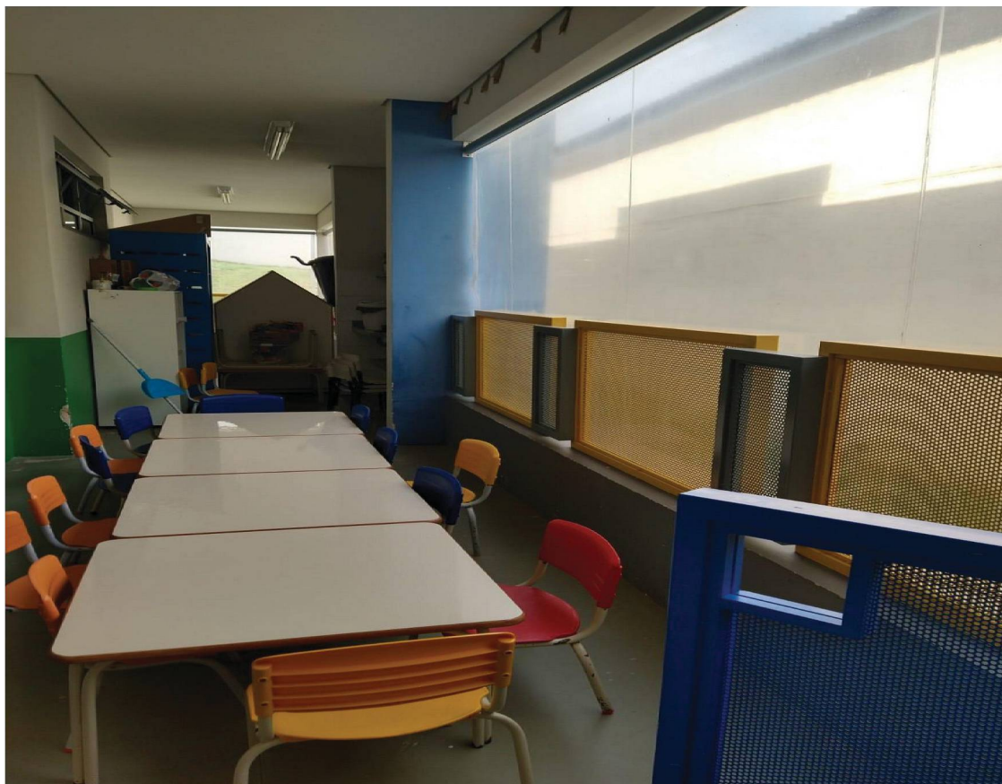
FOTO 14- TOLDOS INSTALADOS NO SOLÁRIO- CMEI BCL
