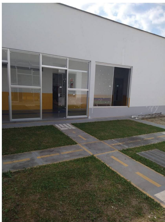
FOTO 06- VIDROS INSTALADOS- CMEI CCL
