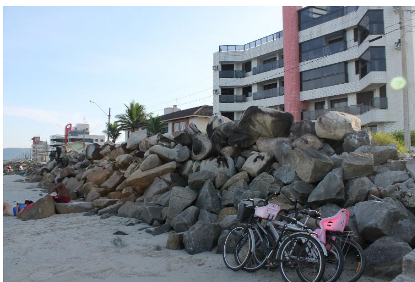
FIGURA 72: EROSÃO NO BAIRRO RIVIERA FONTE: AUTORA, 2016.
