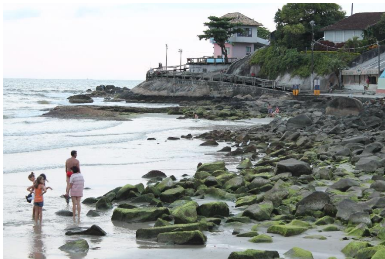
FIGURA 73: EROSÃO NA PRAIA CENTRAL DE MATINHOS FONTE: AUTORA, 2016.
