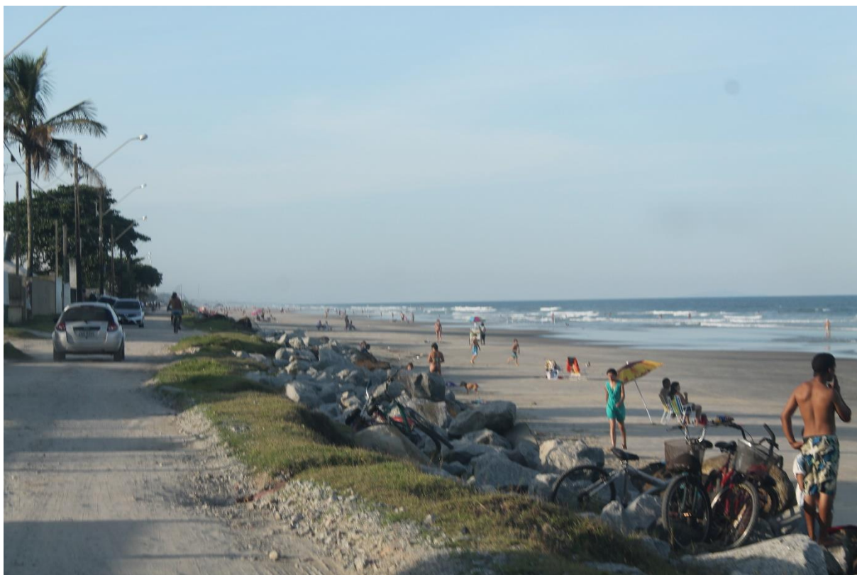
FIGURA 68: EROSÃO MARINHA NO BALNEÁRIO RIVIERA FONTE: AUTORA, 2016.
