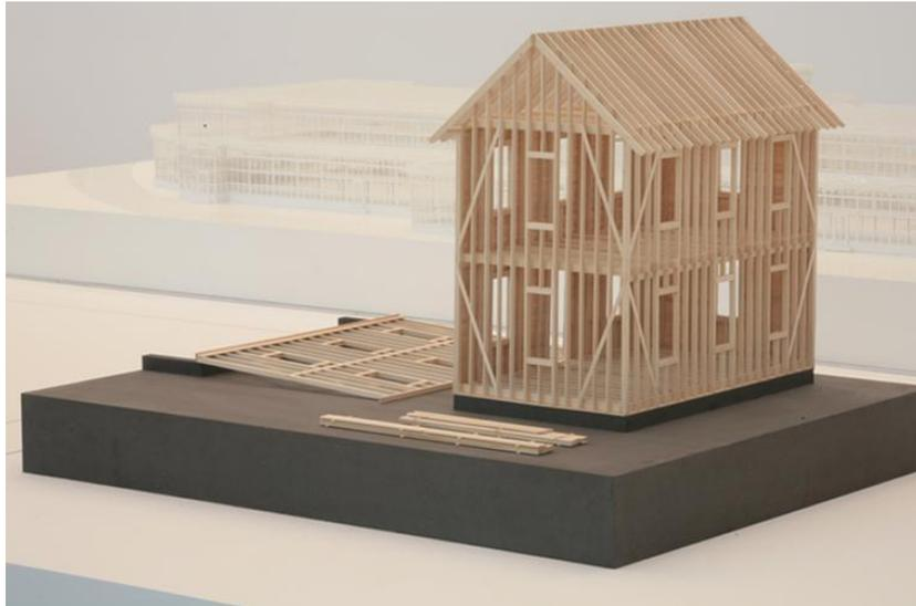
Figura 18 - Representação em maquete do Sistema Balloon Frame (FONTE: KALTENBACH, 2010).
