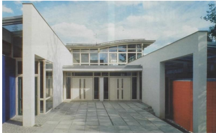
FIGURA 30 – FACHADA PRINCIPAL DA CASA EDITH STEIN
