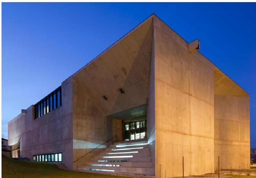
FIGURA 43 – RASGOS NO EDIFÍCIO
