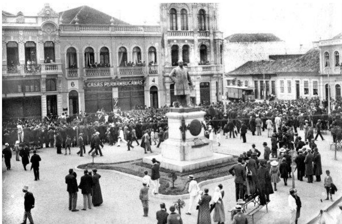
FIGURA 92 - PRAÇA MUNICIPAL (1915). FONTE: PARQUES E PRAÇAS DE CURITIBA.
