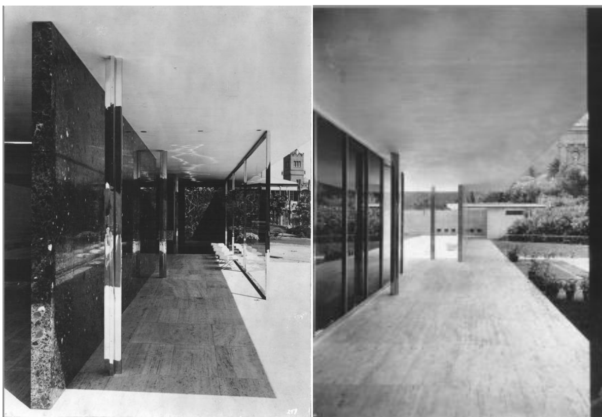
FIGURA 20 - MIES VAN DER ROHE, PAVILHÃO DE BARCELONA (1929). FONTE: WORDPRESS (2013).
