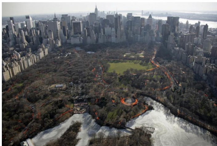
FIGURA 11 - IMAGEM AÉREA DO CENTRAL PARK COM A INSTALAÇÃO THE GATES (2005). FONTE: WOLFGANG VOLZ (2005).
