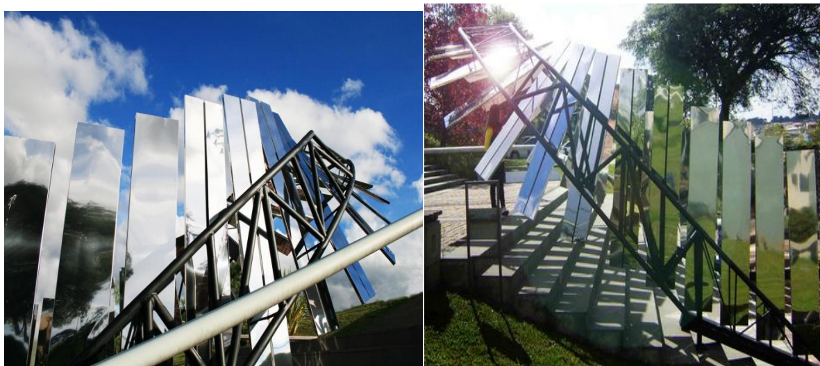
FIGURA 83 - DETALHE DA ESTRUTURA METÁLICA. FONTE: RODRIGO JORGE (2012).
