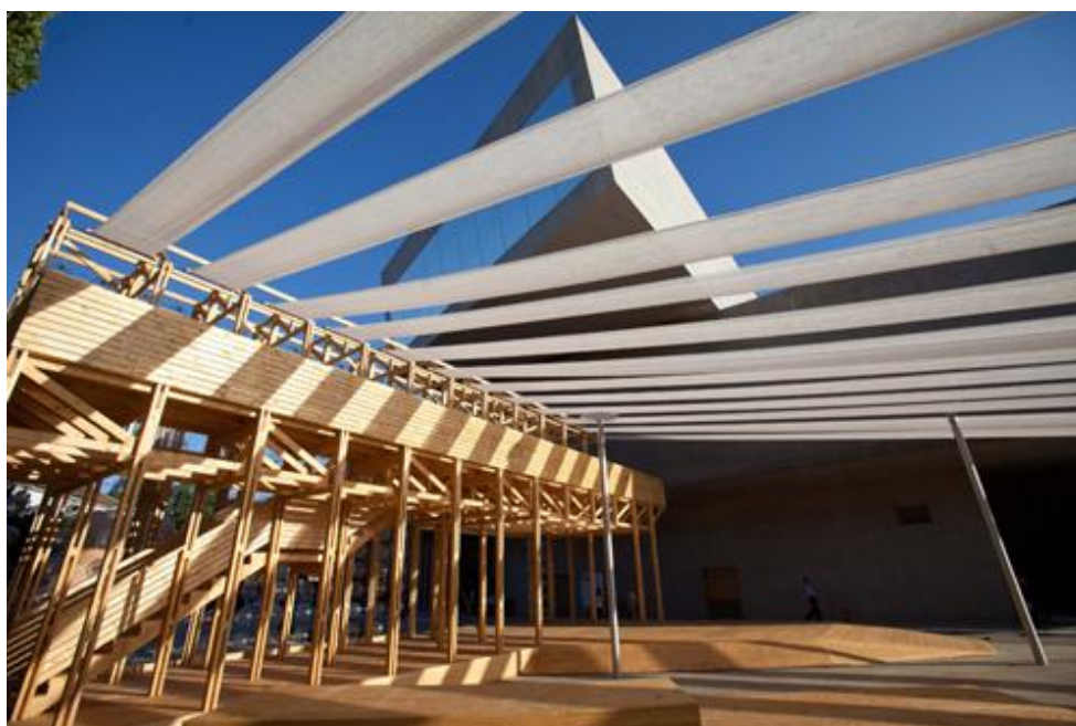
FIGURA 56 - ARENA COM A ESCADA QUE DÁ ACESSO AO NÍVEL SUPERIOR. FONTE: MUSACCHIO IANNIELLO (2014).
