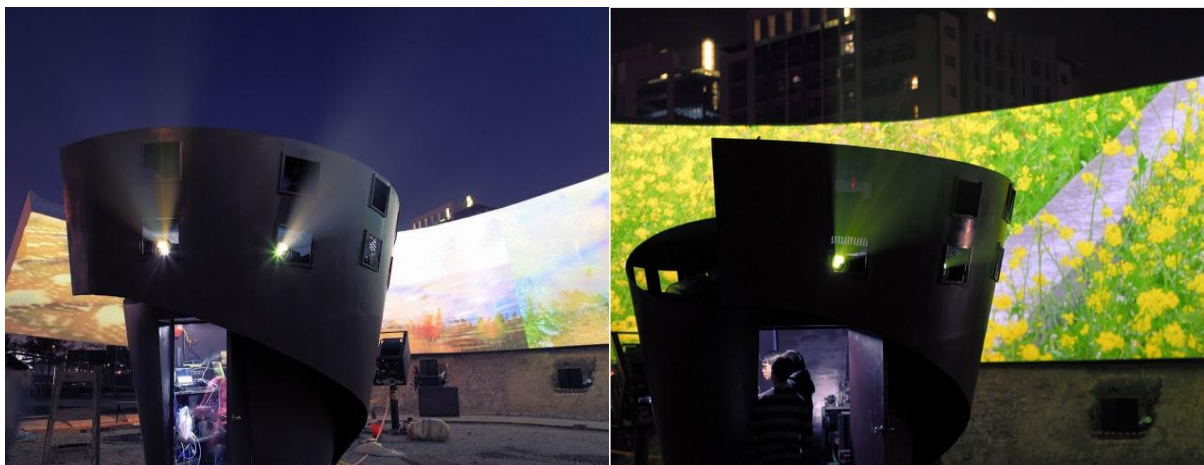
FIGURA 71 - ESTRUTURA DE SUPORTE DOS SISTEMA DE PROJEÇÃO 3D. FONTE: JJ PAN & PARTNERS (2013).
