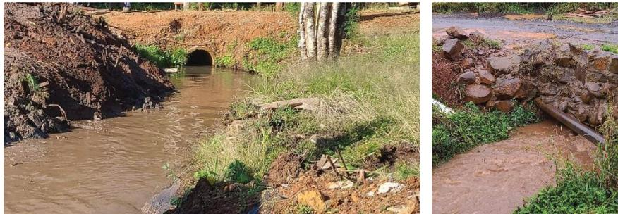
**FIGURA 08:** Manilha e passagem de água no limite da capacidade
