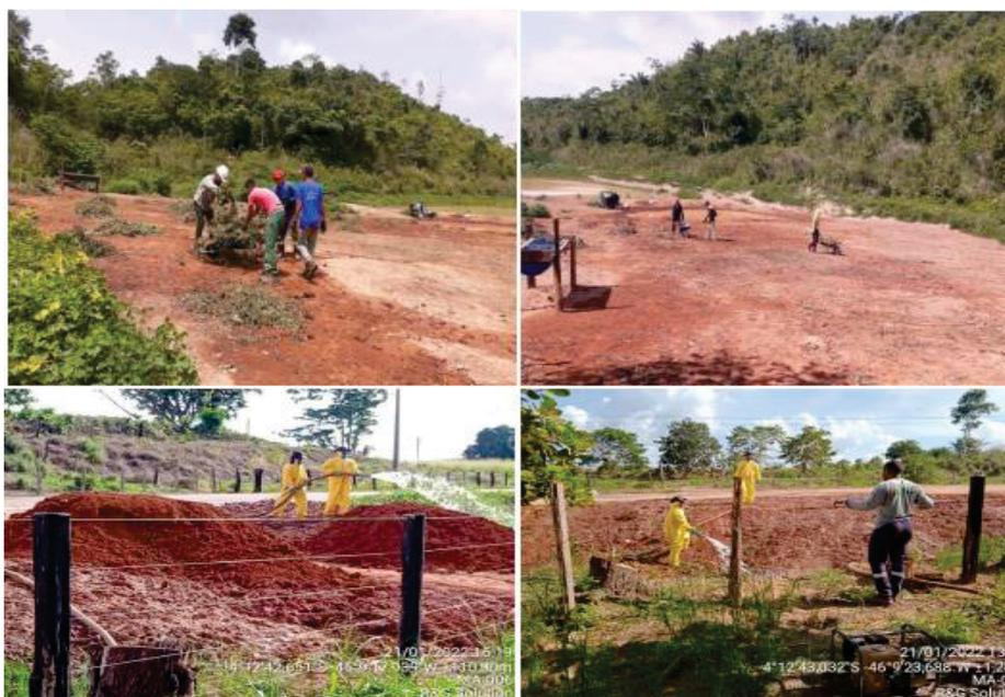
**Figura 3** - Remoção manual de solo e Oxidação Química. Fonte: Dados da Pesquisa (2023).
