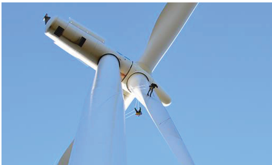
Figura 7 - Manutenção em pás de aerogeradores.
