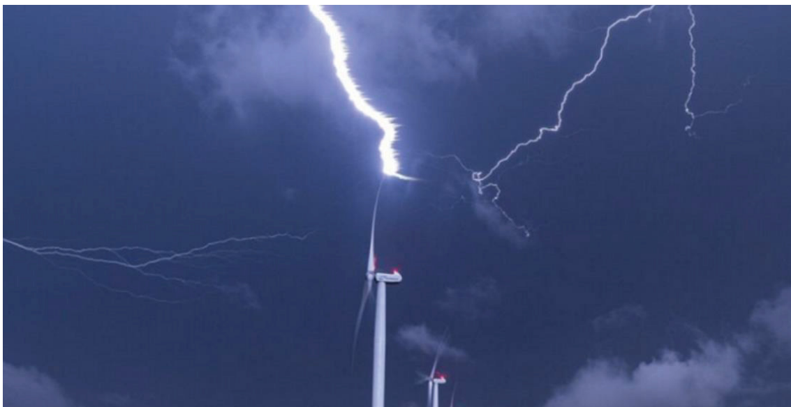
Figura 2 - Descarga atmosférica atingindo a pá de um aerogerador de parque eólico
