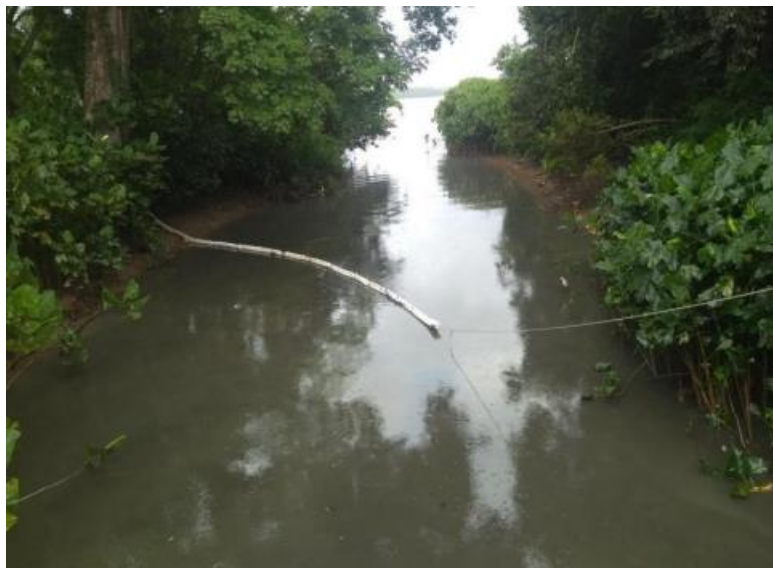
FIGURA 03 - INSTALAÇÃO DA ECOBARREIRA TIPO 2 NO RIO TUCUNDUBA, ESTENDIDA DESDE O CANAL PRINCIPAL ATÉ A MARGEM ESQUERDA
