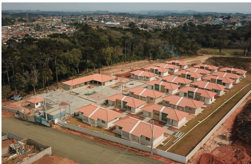
FIGURA 47 – CONTRUÇÃO DO CONDOMÍNIO
