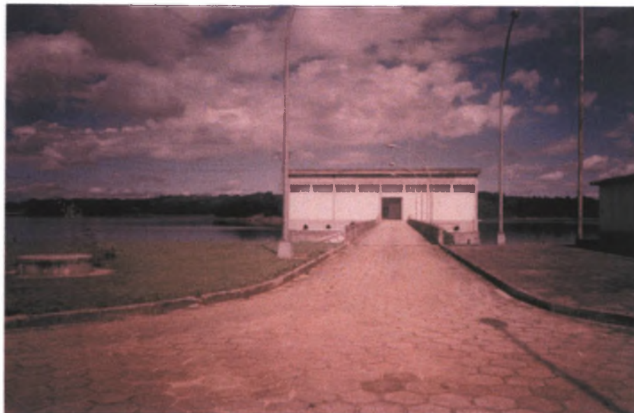
Figura 2.8 – Foto da captação da SANEPAR no reservatório do Passaúna
