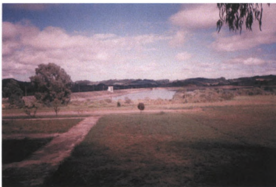
Figura 2.1 – Foto da barragem do reservatório do Passaúna
