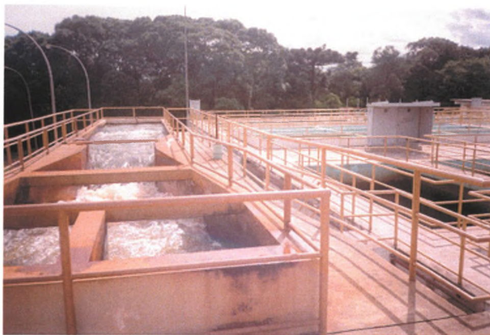
Figura 2.5 – Foto da Estação de Tratamento de Água do Passaúna
