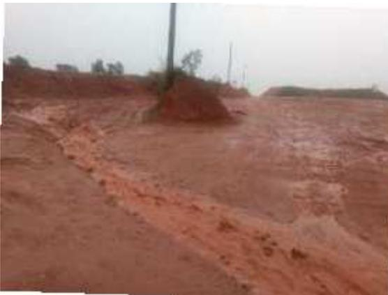
Foto 01: Loteamento em fase de terraplenagem; carregamento de sedimentos
