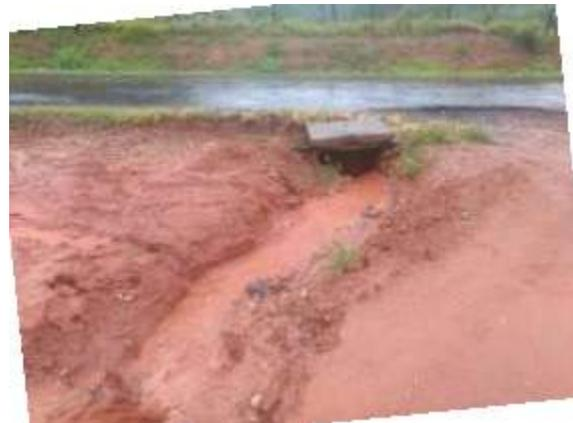
Foto 02: Sedimentos carregados para o sistema de água pluvial.
