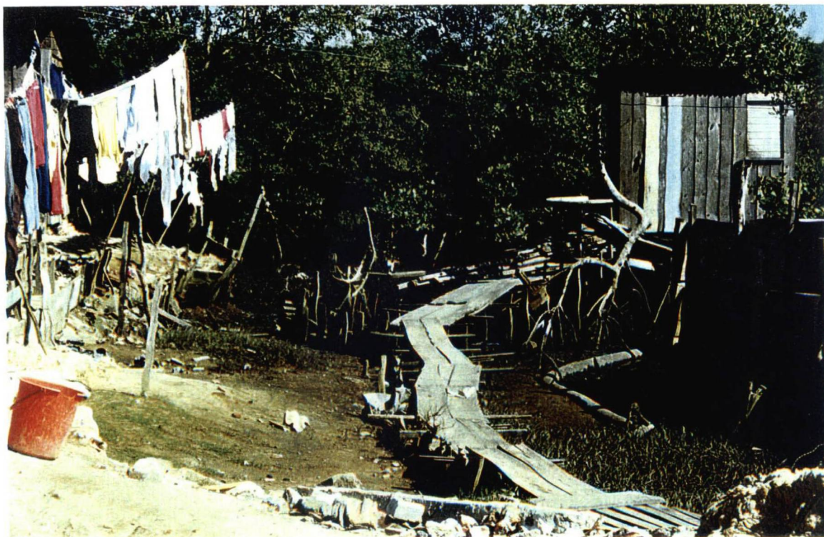
Foto 14 - Construção de palafitas sobre os manguezais (bairro Ponta do Caju – margem esquerda do rio Itiberê) (CANEPARO, S.C., 03.08.99)
