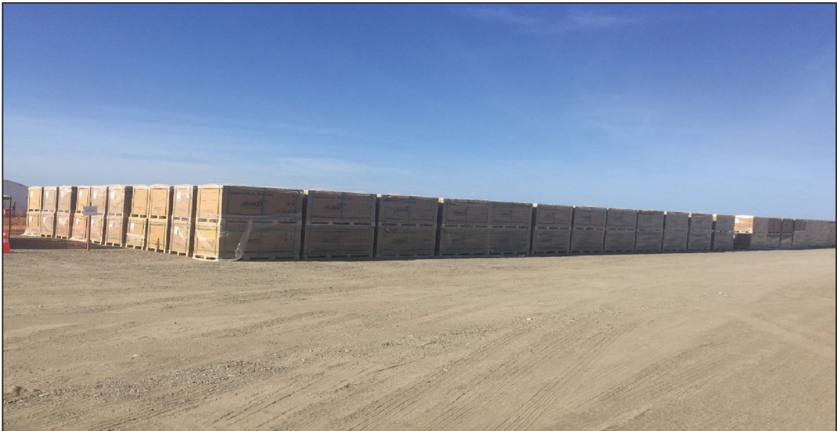
Figura 3: Área de Armazenamento de embalagens de módulos fotovoltaicos.
