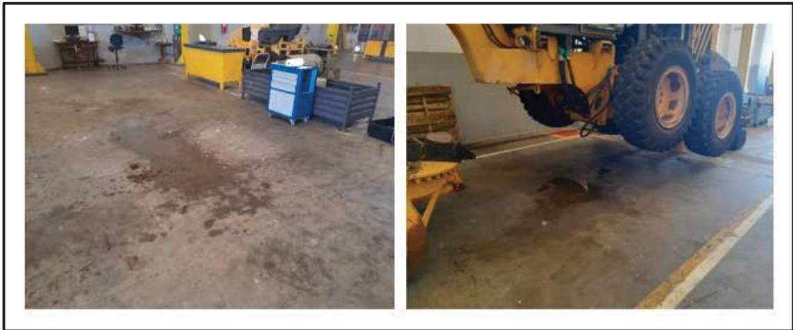
FOTOS 3 e 4 - VAZAMENTO DE ÓLEO LUBRIFICANTE USADO NA OFICINA EQUIPAMENTOS EM MANUTENÇÃO
