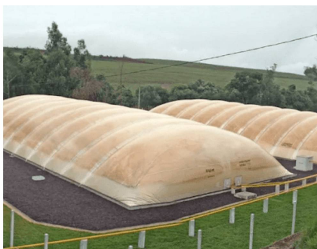
Figura. 06: Biodigestor modelo canadense.
