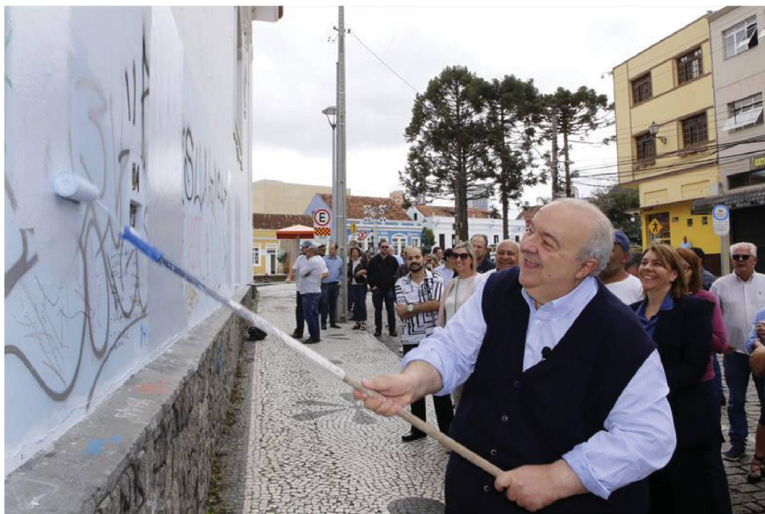
Figura 6 - Prefeito Rafael Greca aplica resina antipichação na fachada da Igreja do Rosário durante o lançamento do programa Rosto da Cidade
