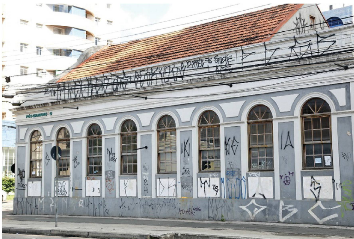
Figura 8 - Imóvel da Avenida Visconde de Guarapuava, que ilustra reportagem da CMC
