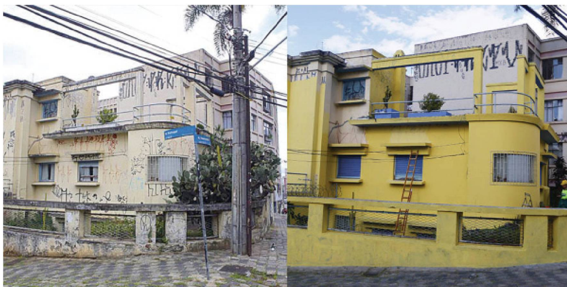
Figura 9 - Casa Frederico Kirchgässner: “o antes e depois da despichação”
