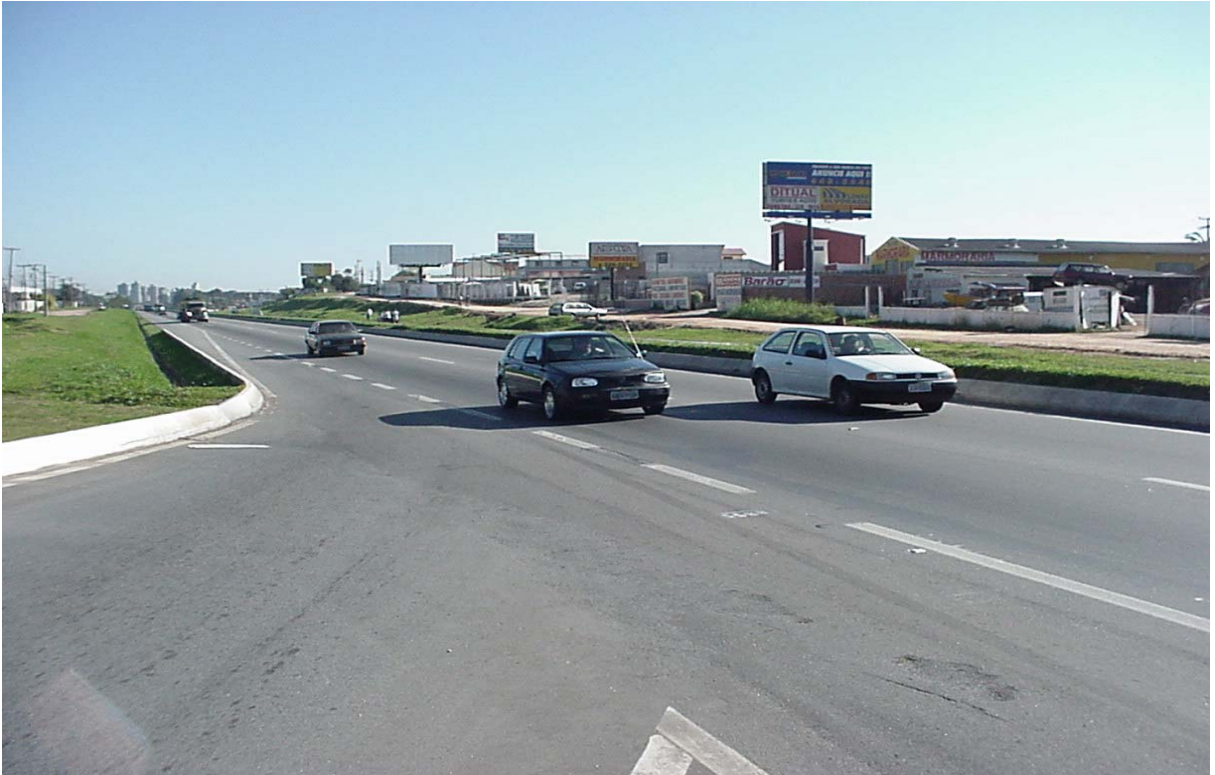
FIGURA 4.4 – VISTA DAS CONDIÇÕES DE UM LOCAL DE MEDIÇÃO – 1
