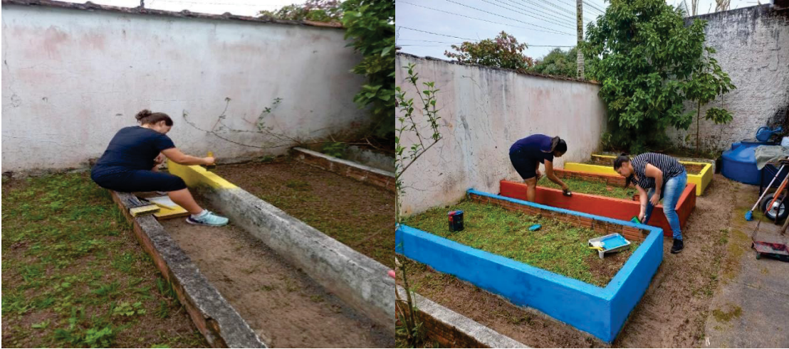
Figura 16 – Mães no processo de revitalização dos canteiros
