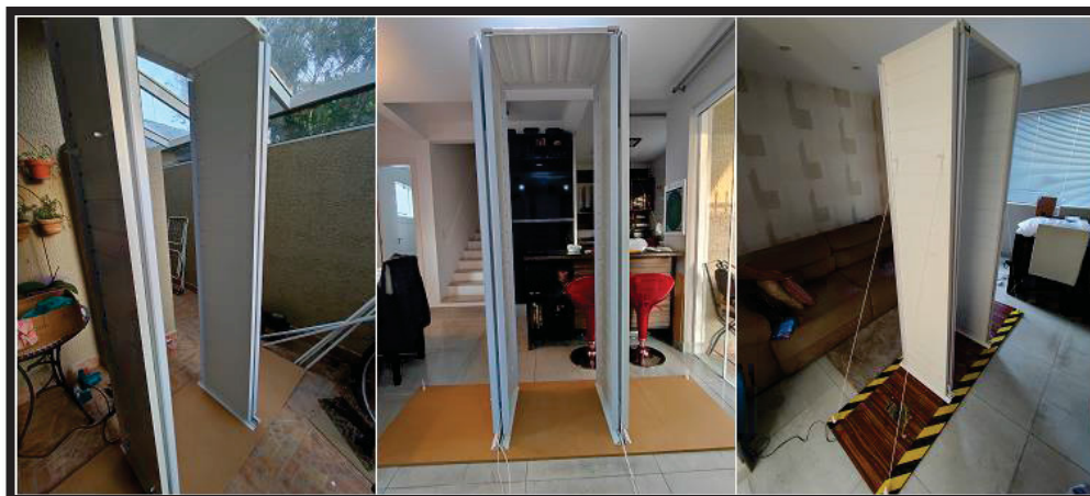
Figura 29 - Etapas da Construção da Estrutura do Portal Detector de Metais.
