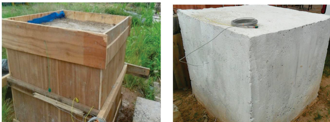
Figura 46 – Bloco experimental concretado e nas idades iniciais após desforma.
