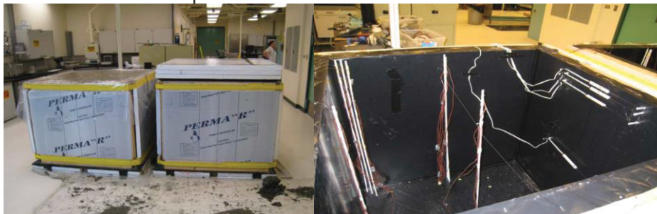
Figura 49 – Blocos de concreto experimentais e a vista interna da fôrma antes da concretagem.
