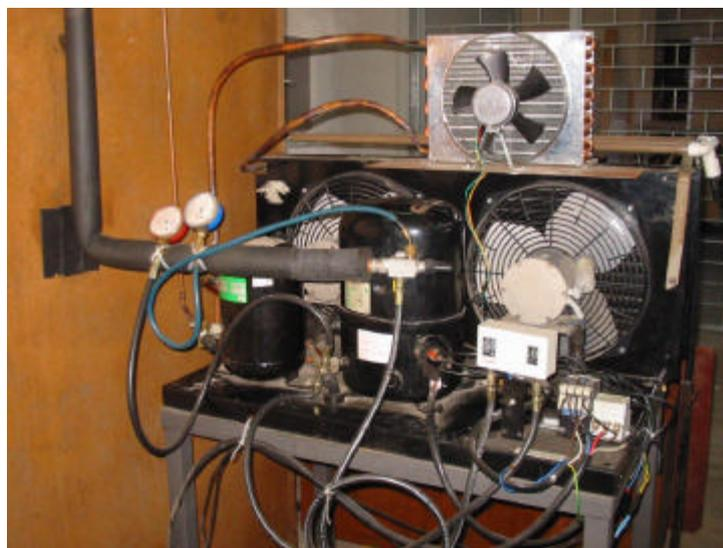
*Figura 4: Unidade Condensadora.*
