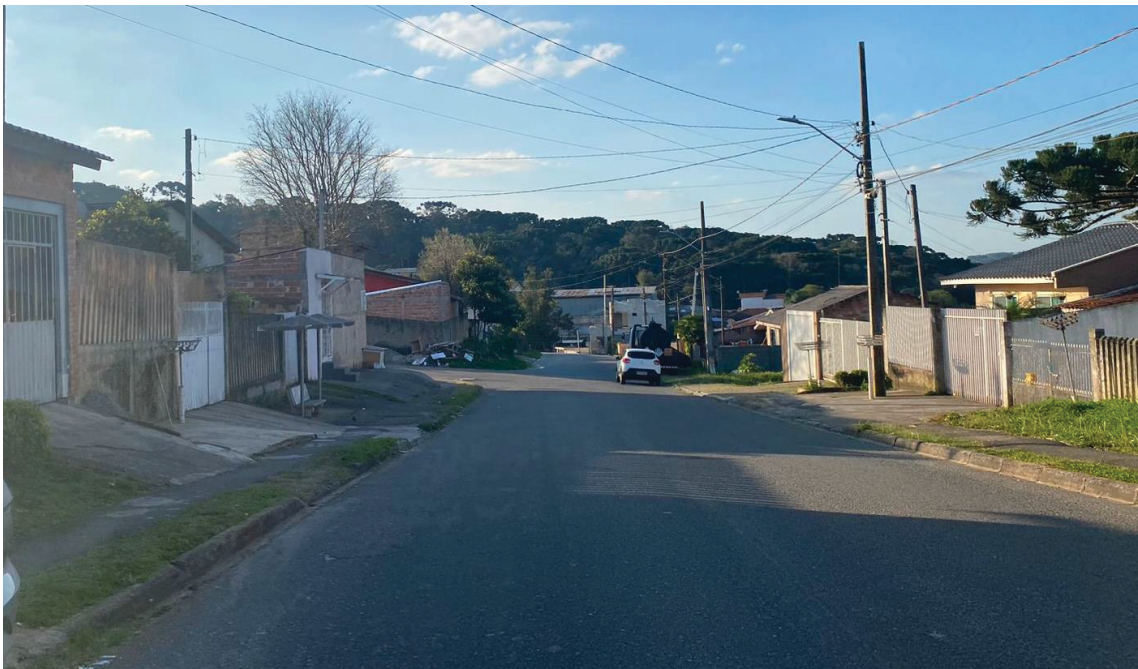
FIGURA 36 – DESCONTINUIDADES DEVIDO AS RAMPAS DE ACESSO DE VEÍCULOS – COLOMBO, 2023
