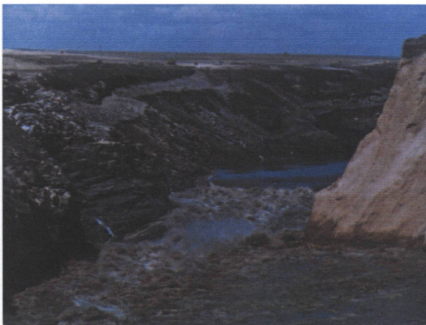
FIGURA 4.20 - BARRAGEM DE TETON - FINAL DA TARDE
