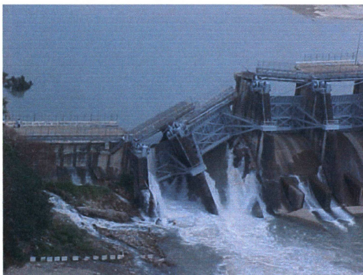
4.22 – BARRAGEM DE SHIH-KANG APÓS O TERREMOTO
