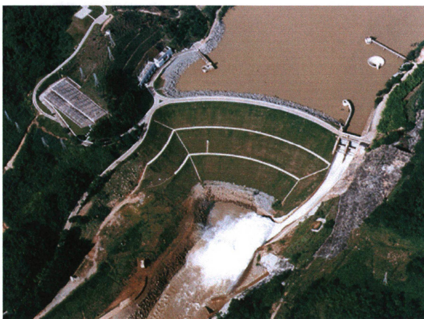
FIGURA 4.12 - BARRAGEM DE EUCLIDES DA CUNHA
