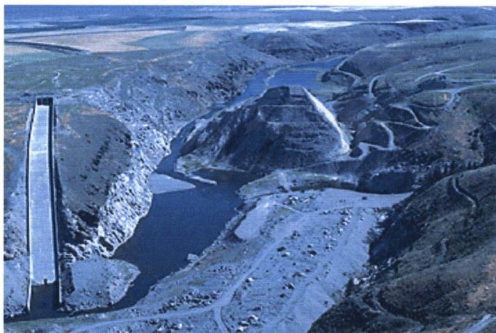
FIGURA 4.21 – BARRAGEM DE TETON APÓS A RUPTURA
