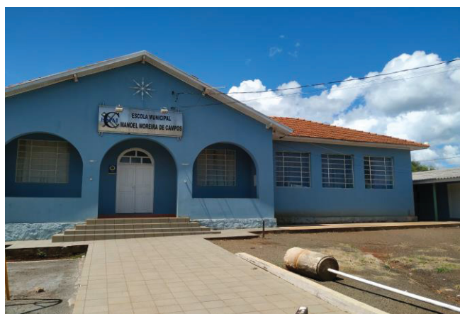
Figura 11: Escola Municipal na sede de Palmeirinha. Fonte: Trabalho de Campo (2022).
