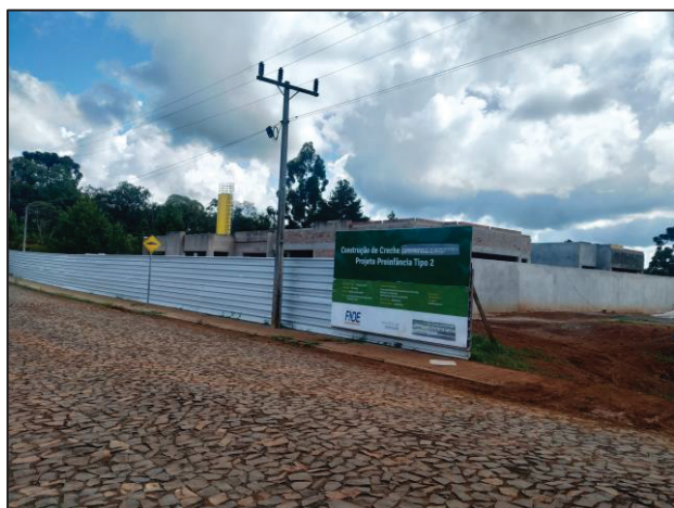
Figura 19: Construção de Creche com recursos federais. Fonte: Trabalho de Campo (2022).
