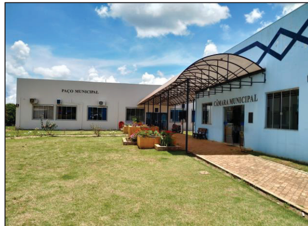
Figura 16: Atual Prefeitura Municipal. Fonte: Trabalho de Campo (2022).
