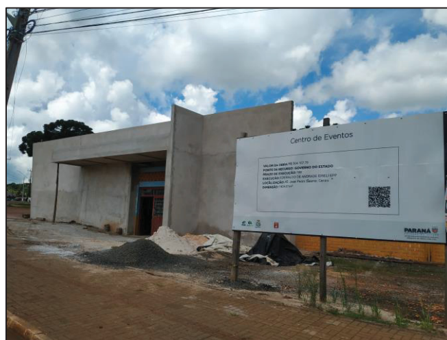
Figura 18: Construção de Centro de Eventos com recursos estaduais, 2022. Fonte: Trabalho de Campo (2022).
