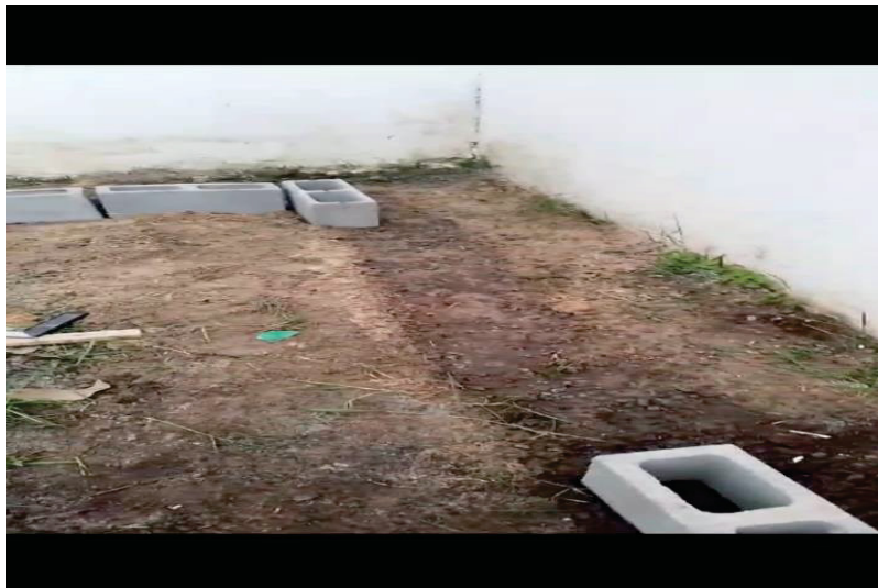
FIGURA 3 - Preparação do espaço para a construção.
