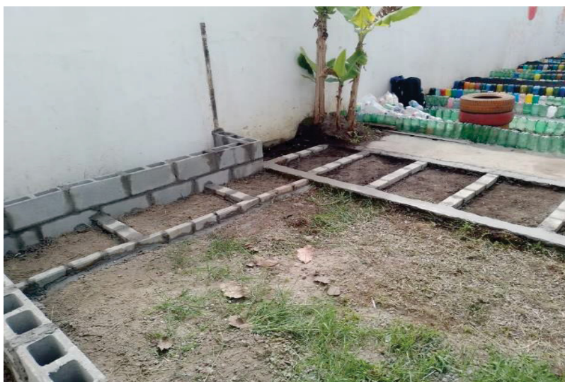
FIGURA 5 - Canteiro e caminho sensorial concluídos.
