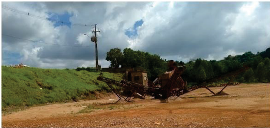
FIGURA 12 - ÁREA DE RECICLAGEM DE RCC CLASSE A LOCALIZADA EM LONDRINA/PR
