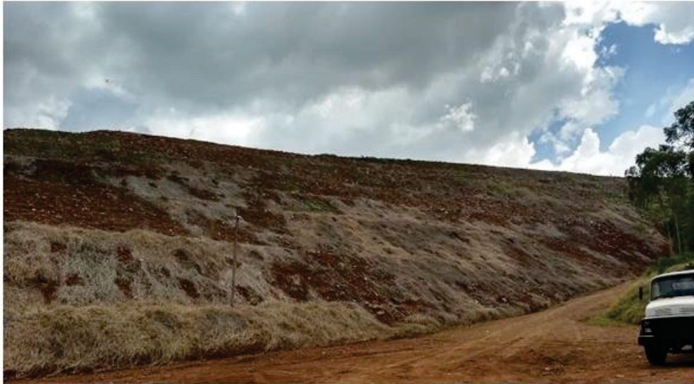
FIGURA 11 - ATERRO DE RCC CLASSE A LOCALIZADO EM LONDRINA/PR
