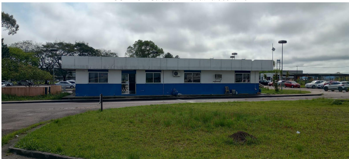
FIGURA 9 – Sala administrativa dos táxis
