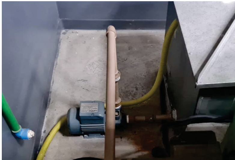
Figura 20 – Sistema de arrefecimento do dinamômetro
