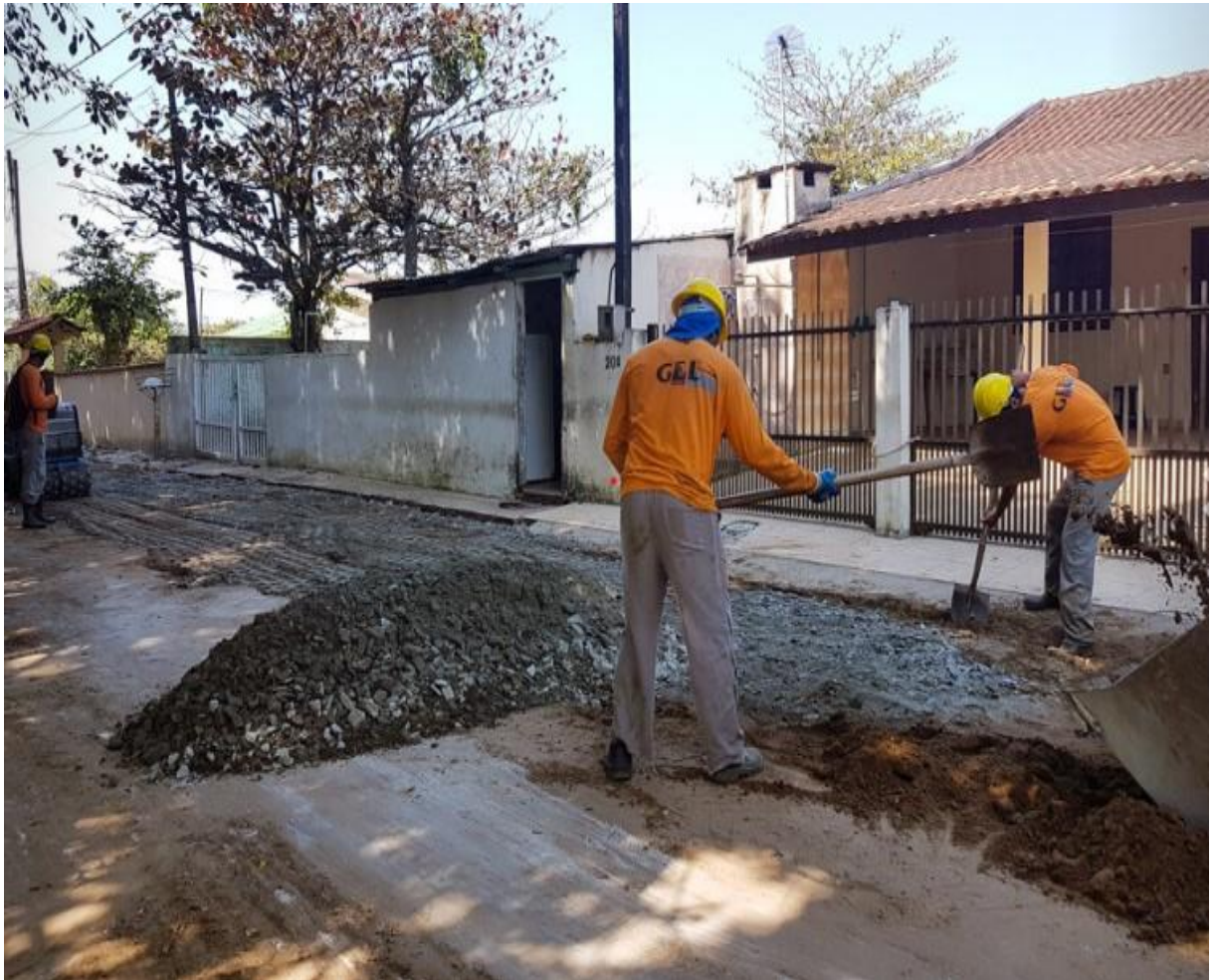
FIGURA 11 – Preparação com camadas de pedra na rua Apucarana
