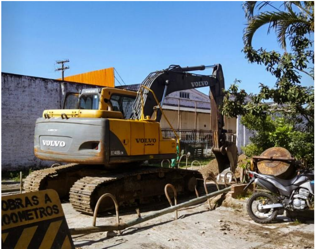
FIGURA 9 – Obras de rede de esgoto na rua Novo Horizonte
