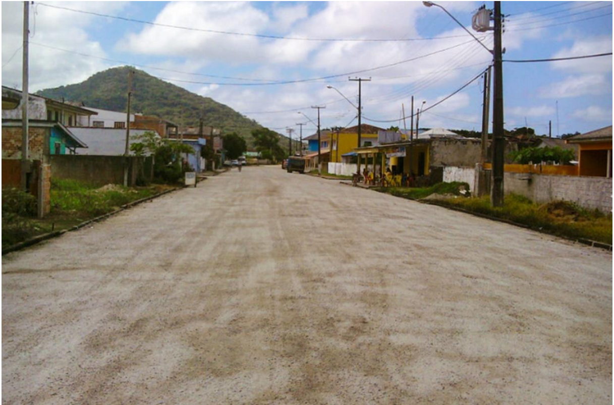
FIGURA 7 – Tratamento antipó (TAP) da rua Realeza
