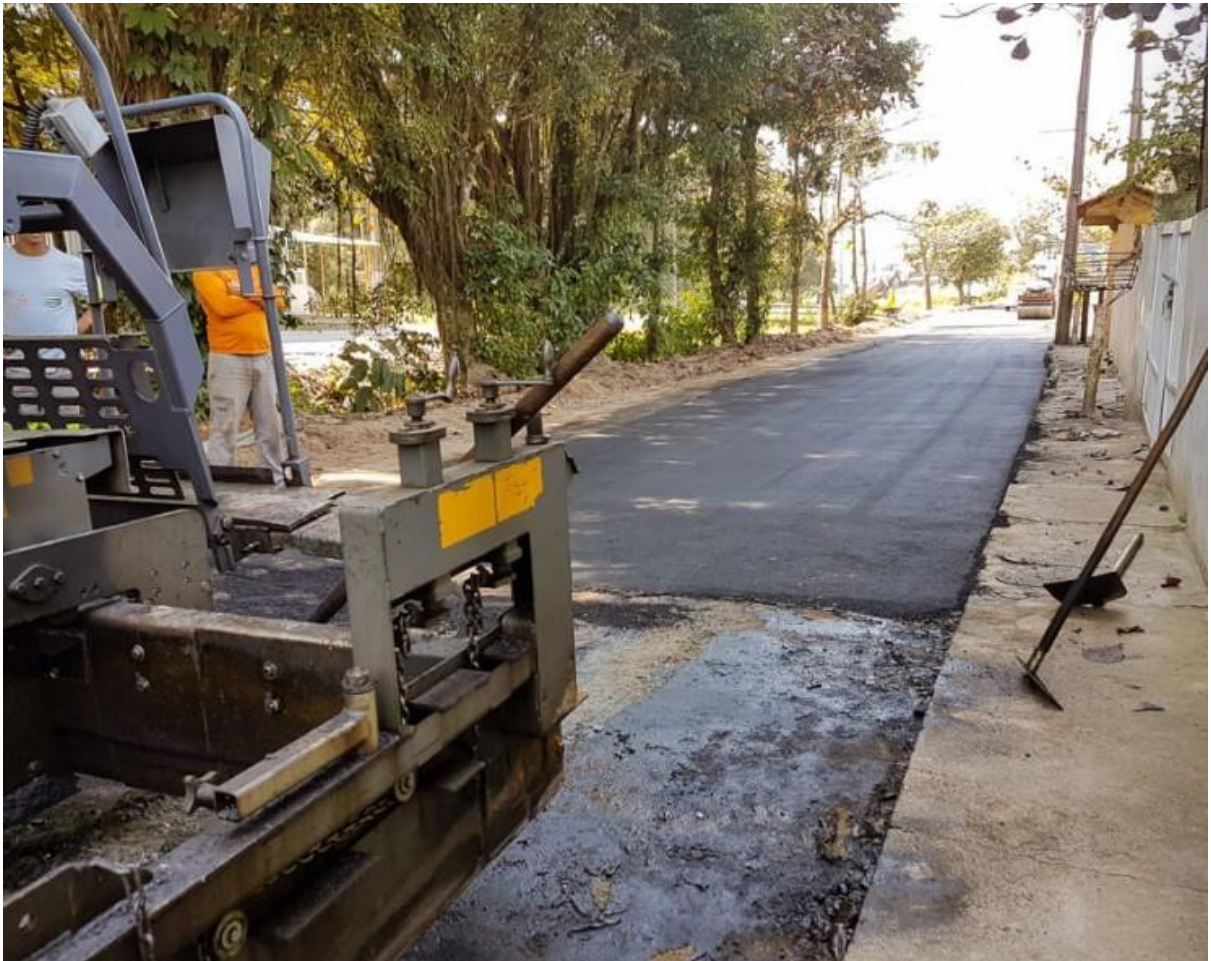
FIGURA 12 – Aplicação do pavimento na rua Apucarana
