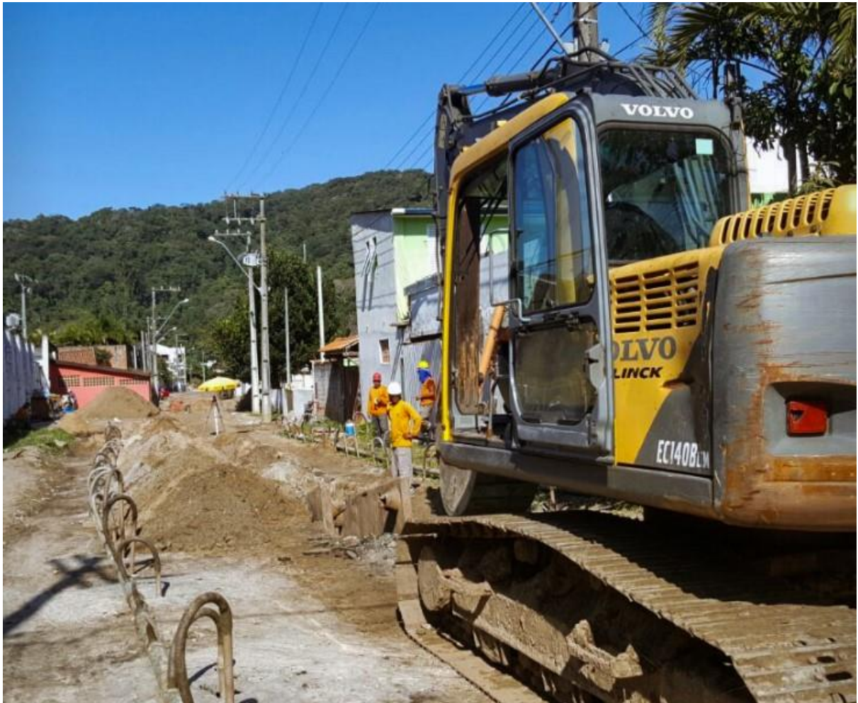
FIGURA 8 – Obras de esgotos na rua Novo Horizonte, nos fundos do atual Super Rede Atacado
