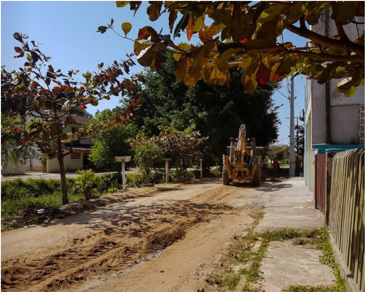
FIGURA 10 – Preparação para a implantação de asfalto na rua Apucarana
