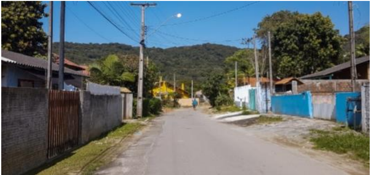
FIGURA 13 – Rua com pavimentação
