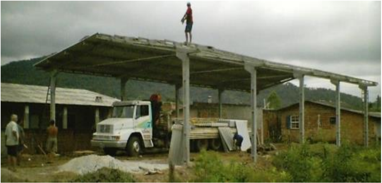
FIGURA 4 – Construção da sede da Associação de Moradores
