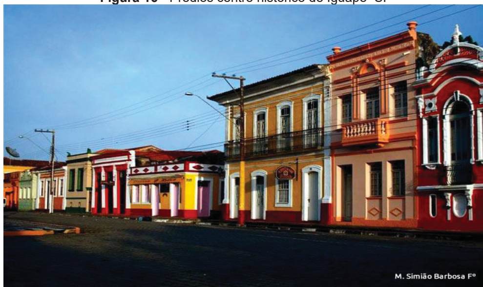
Figura 16 - Prédios centro histórico de Iguape–SP
