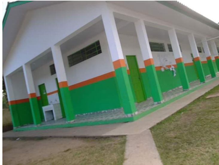
Figura 5 - Escola Nuclearizada São Sebastião
