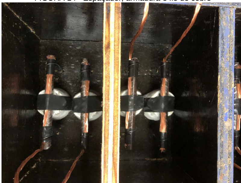
FIGURA 14 - Espaçador, armadura e fio de cobre
