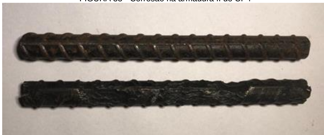
FIGURA 35 - Corrosão na armadura II do CP4
