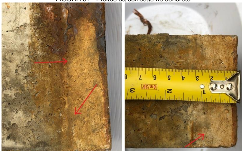
FIGURA 37 - Efeitos da corrosão no concreto
