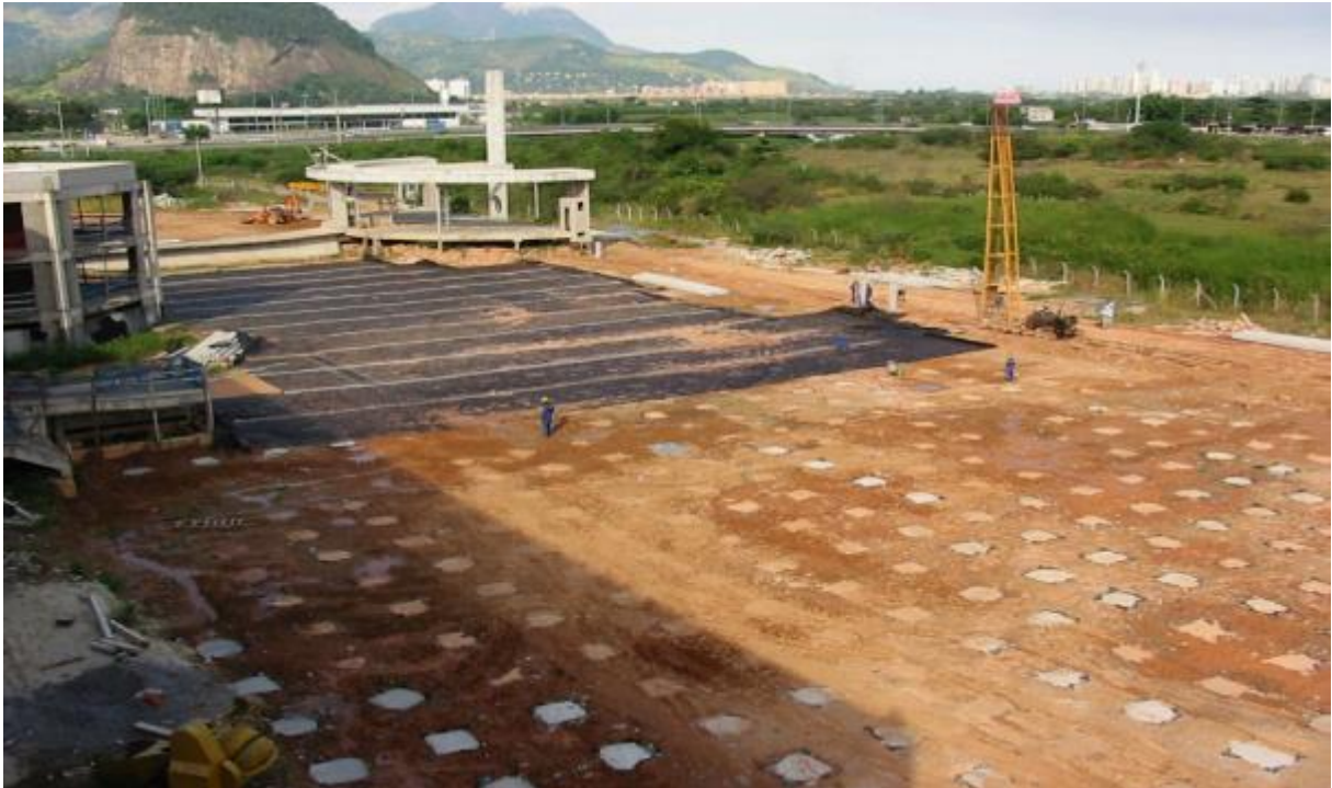
Figura 7 – Aterro estruturado com reforço geossintético
