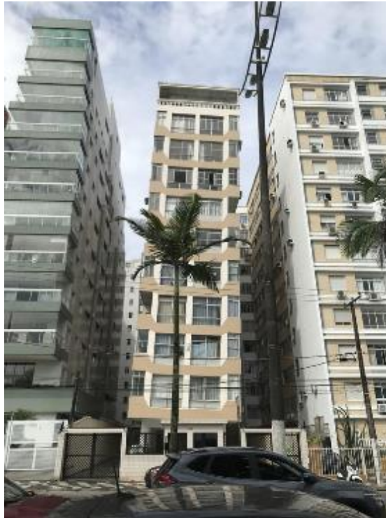
Figura 3 - Prédio inclinado na orla de Santos
