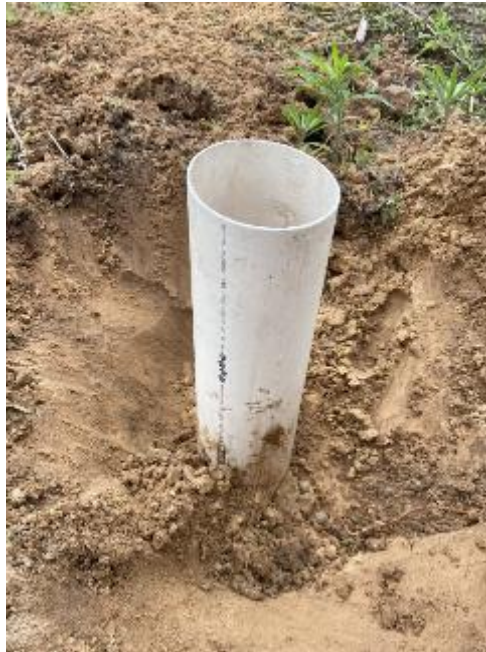
Figura 11 - Escavação ao redor do amostrador
