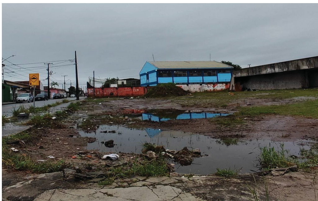
FIGURA 17 – Terreno ao lado da escola estadual Carmen Costa Adriano - Paranaguá/PR II
