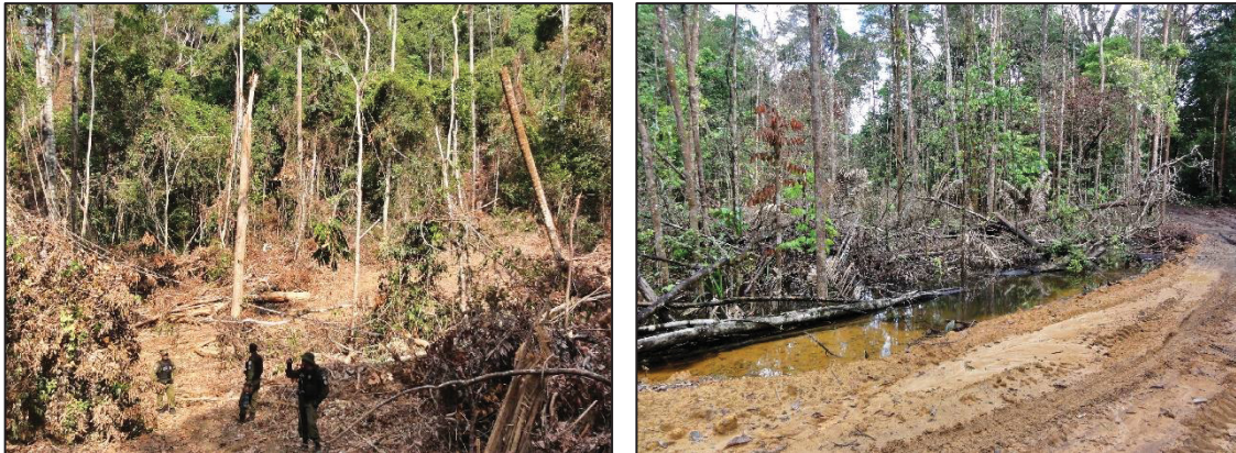
FIGURA 14 - DEMONSTRATIVO DOS DANOS OCACIONADOS PELA FALTA DE PLANEJAMENTO NA CONSTRUÇÃO DE ESTRADAS E EXECUÇÃO DO ARRASTE
