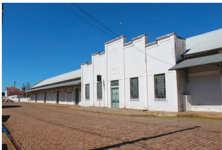
FIGURA 10 – Edificação da antiga estação ferroviária, integrante do patrimônio ferroviário em Campo Grande. Utilizada por órgãos do Governo Estadual e para realização de eventos públicos
