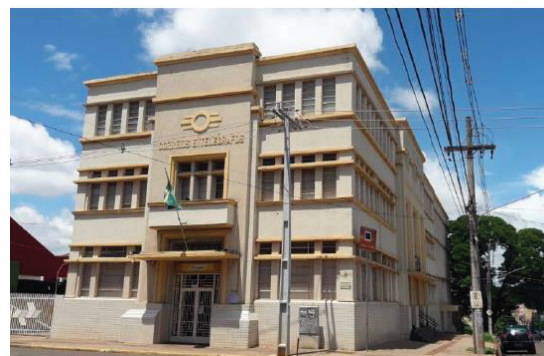
FIGURA 21 – Edifício dos Correios, parte integrante do patrimônio material da cidade
