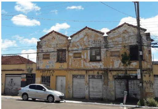
FIGURA 20 – Edificação em estado de abandono na Av. Calógeras
