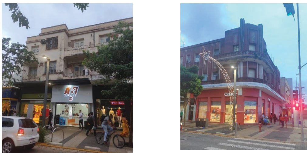
FIGURA 24 – Edificações de sobrelojas abandonadas na R. 14 de Julho
