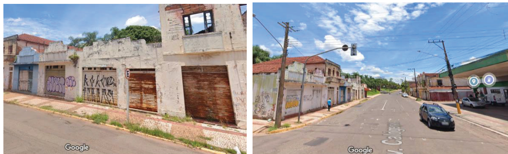
FIGURA 23 - Conjunto de imóveis abandonados e em alto grau de degradação, localizados na Av. Calógeras
