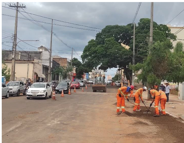
FIGURA 27 – Obras de revitalização da região central
