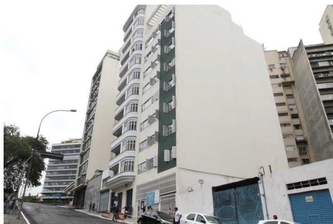
FIGURA 36 – Edifício Asdrúbal do Nascimento, voltado para população em situação de rua
