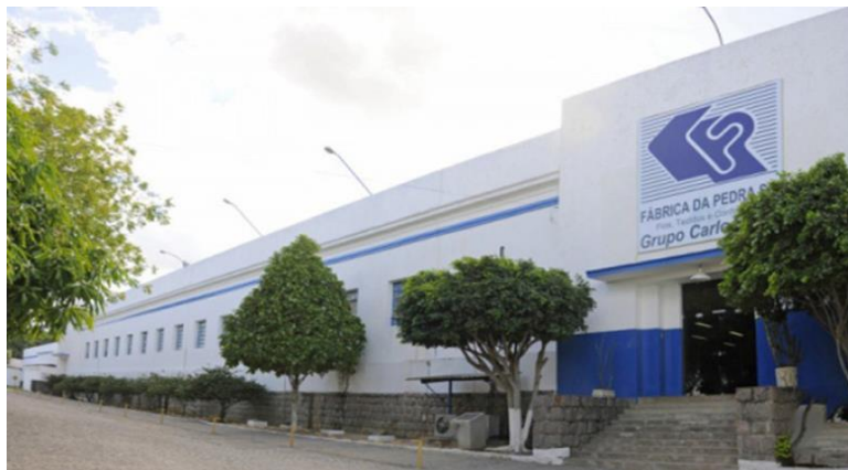
Figura 11 - Foto atual da fachada da Fábrica da Pedra
