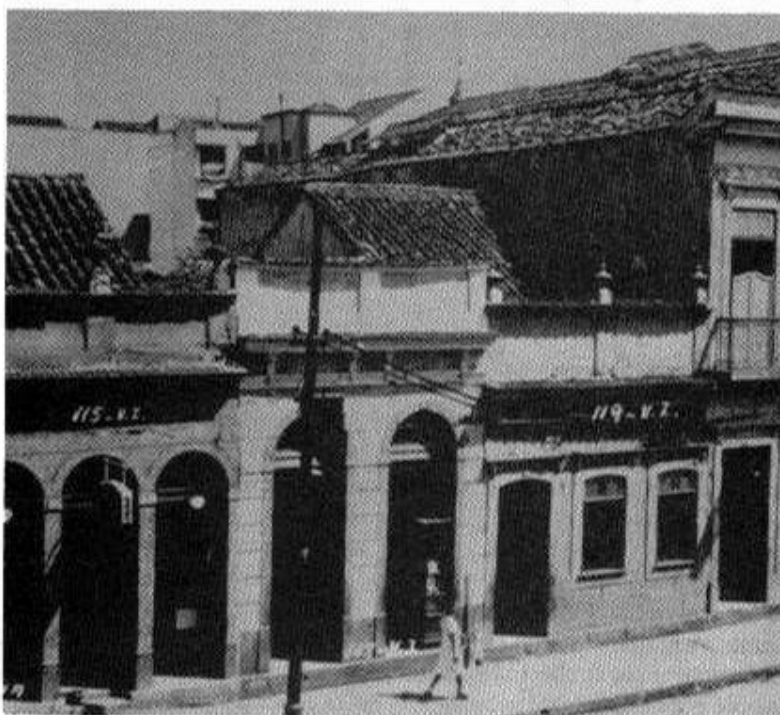
Trecho da rua Visconde de Itaúna, em 19 de julho de 1941, pouco antes de ser demolido para a abertura da avenida Presidente Vargas, inaugurada em 1944. Único documento fotográfico da casa de Tia Ciata, assinalada pelo nº119. (Embora os livros que tratam do assunto indiquem o nº117, a descrição dos que freqüentavam a casa corresponde ao 119.) (AGCRJ. Fotógrafo não identificado).
