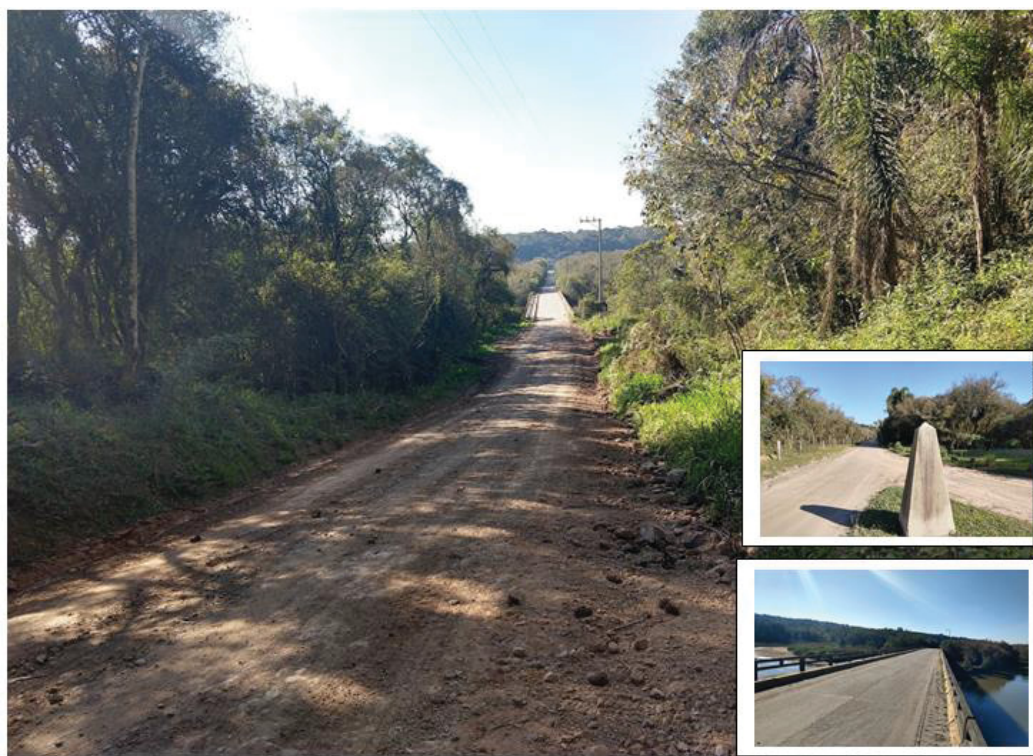
FIGURA 10 - Ponte de Concreto
